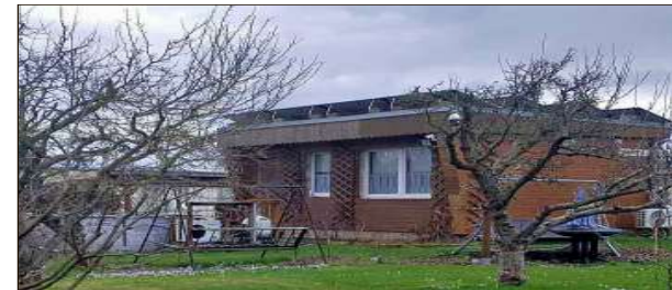
Kleingärtner Marcel Schreimb aus Wittenberg hat auf dem Dach seiner Gartenlaube Solarpaneele angebracht.
